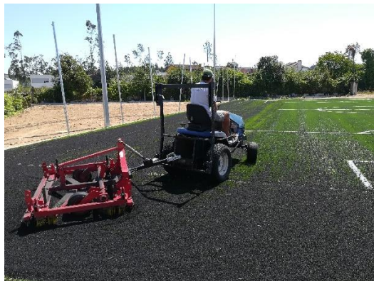
Fig. 8 – Escovagem do relvado sintético para regularização das cargas de borracha.
