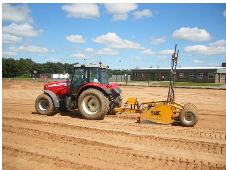
Fig. 1 – Nivelamento do terreno base, antes do espalhamento e nivelamento da camada de tout-venant.
