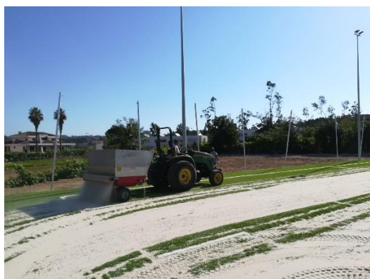
Fig. 7 – Espalhamento de cargas de areia de sílica.
