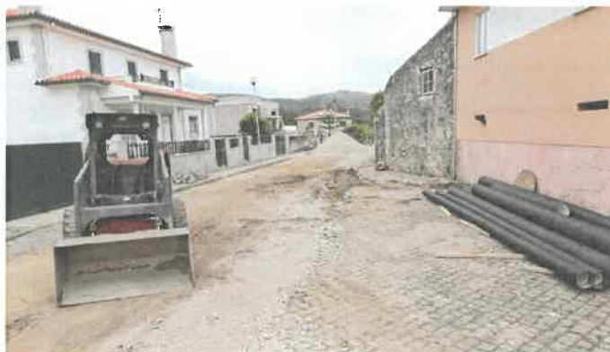
Figura 25 - Saneamento de Aspra, Viso, Currais e Igreja - freguesia de Âncora 28
