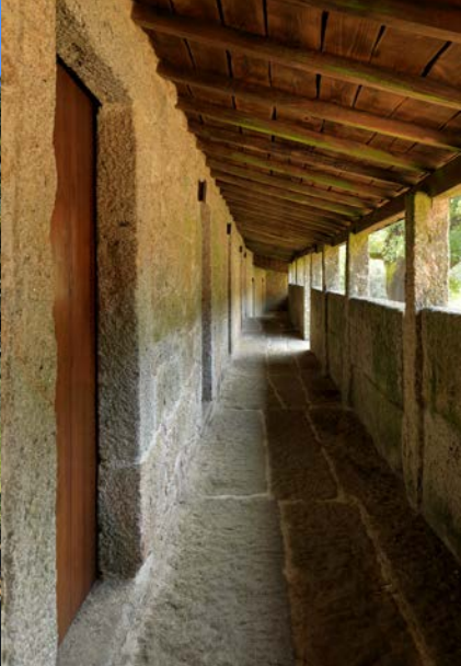
Galeria alpendrada dos quartéis
